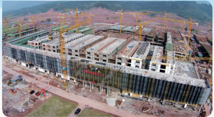
CSC Chongqing under construction 在建中的重慶華南城
