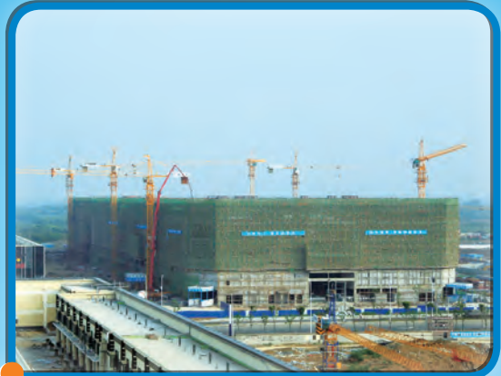
CSC Hefei under construction 在建中的合肥華南城
