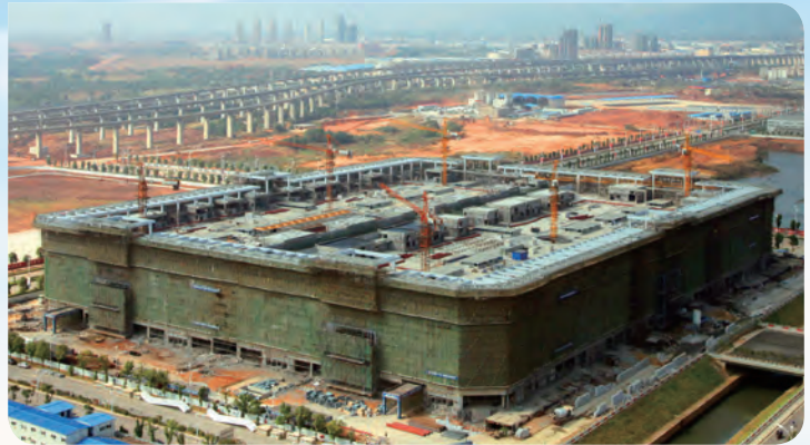
Trade center under construction 在建中的交易廣場
