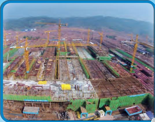
CSC Chongqing under construction 在建中的重慶華南城
